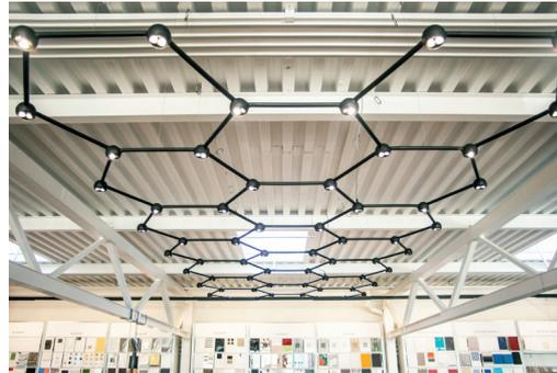
Das modulare Lichtnetz FAVO (THE) LIGHT NET bietet die ideale Flexibilität für die Beleuchtung der Fläche für wechselnde Ausstellungen im Obergeschoss.
